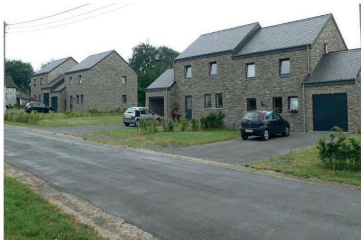
Les Tailles : architecture dite « d'intégration » assez réussie en termes de volumétrie, matériaux et couleur
