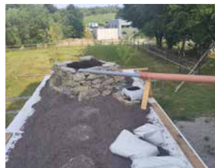
Aménagement d'un toit végétalisé
