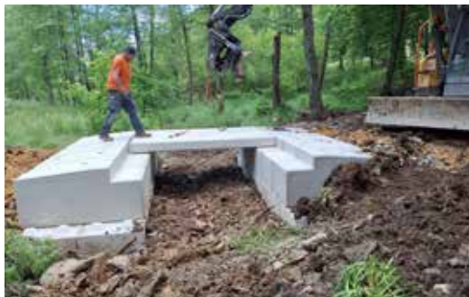
Les dalles sont dimensionnées pour le passage des charrois lourds
