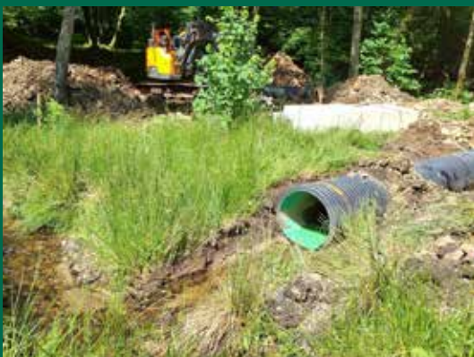
Le cours d'eau est d'abord dévié et l'ouvrage mis à sec pour éviter tout impact durant les travaux
