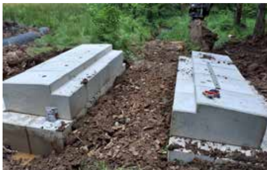
Remblaiement entre les culées avec un matériau adapté suivant la pente naturelle
