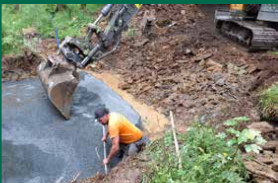
Mise à niveau d'un lit de grenailles pour la pose des culées
