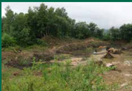
Terrassement en cours
