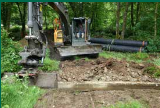
L'ancien ouvrage est supprimé et les débris évacués
