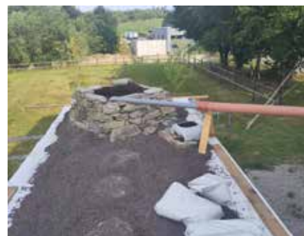
Aménagement d'un toit végétalisé
