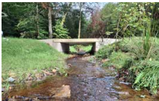
Sous le nouveau ponceau, la rivière libérée retrouve un lit naturel
