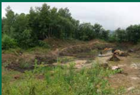
Terrassement en cours
