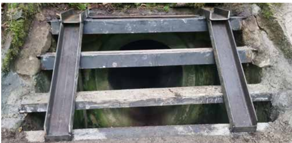
Aménagement de l'ardoisière Saint Joseph
