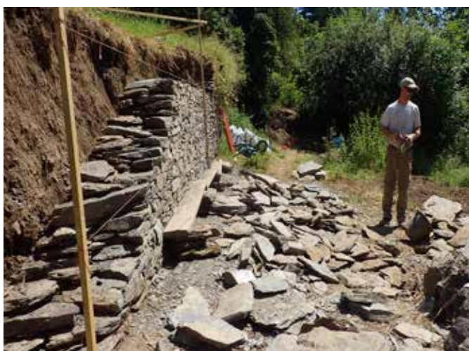
Restauration d'un mur en pierre sèche, Parc naturel des deux Ourthes
